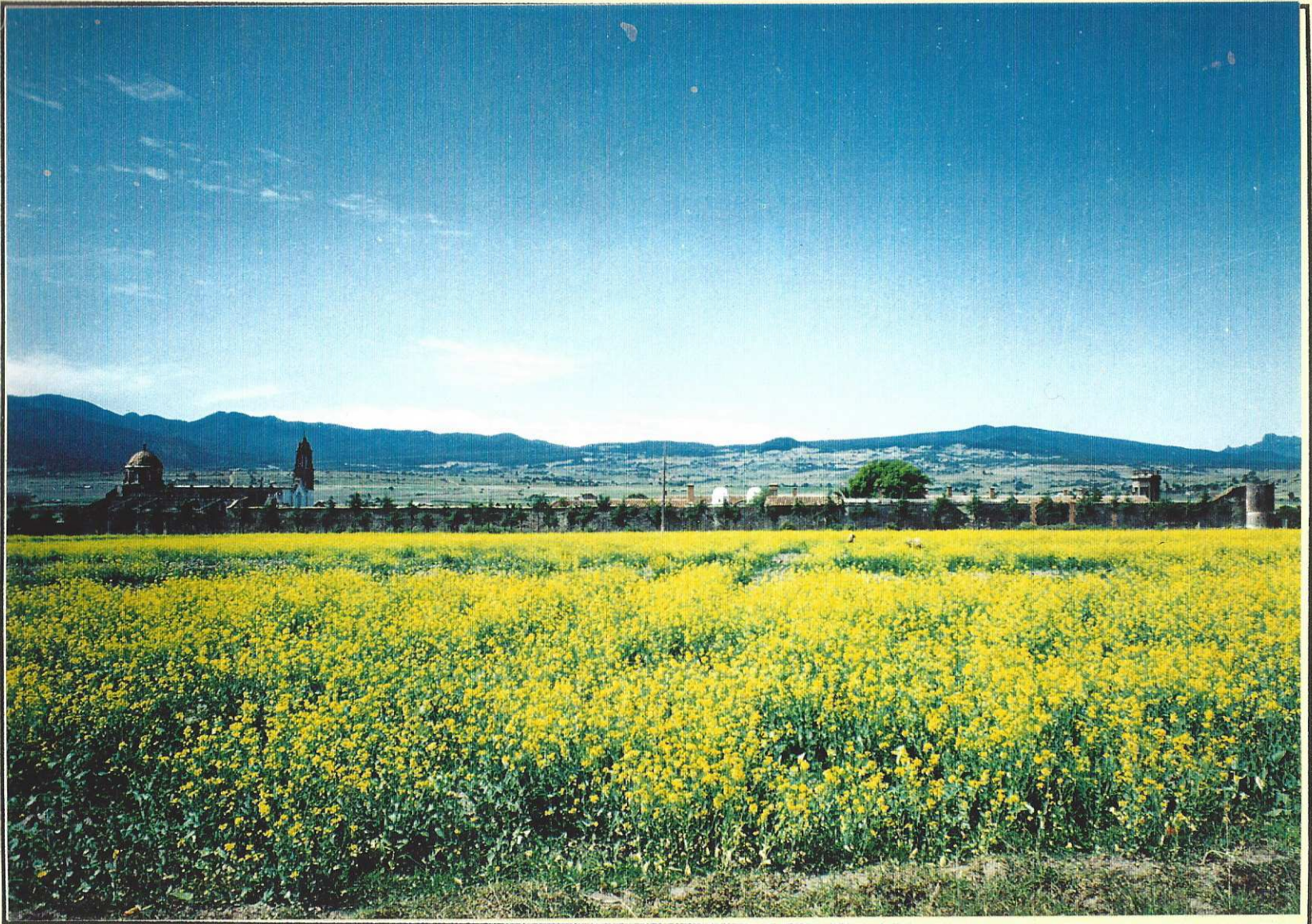
Panorámica de la fachada norte de la Hacienda Atlamaxac.
